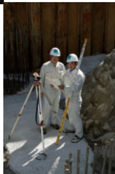
三川町ビル新築工事 撮影日：2007年9月25日
