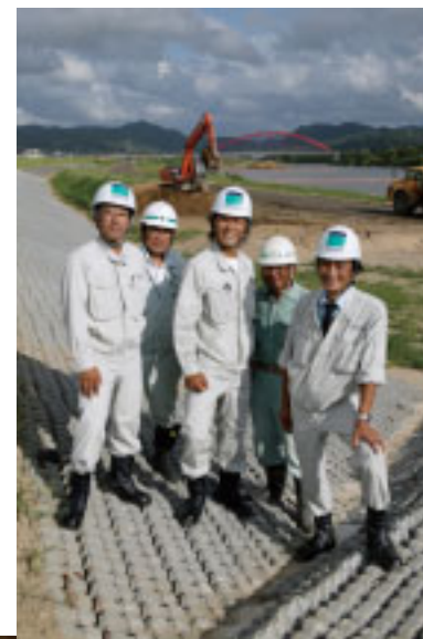
斐伊川放水路高松地区水路工事 2007年9月26日
