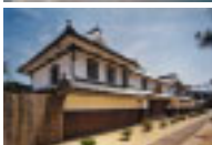
あかりの館 (旧吉田邸) (平成6年竣工／広島県呉市) 木造2階建 (移築工事) 山口県上関町より商家を移築復元
