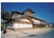
蘭島閣美術館 (平成3年竣工／広島県呉市) 構造: 木造2階建 (新築工事) 本格的な木造建築
