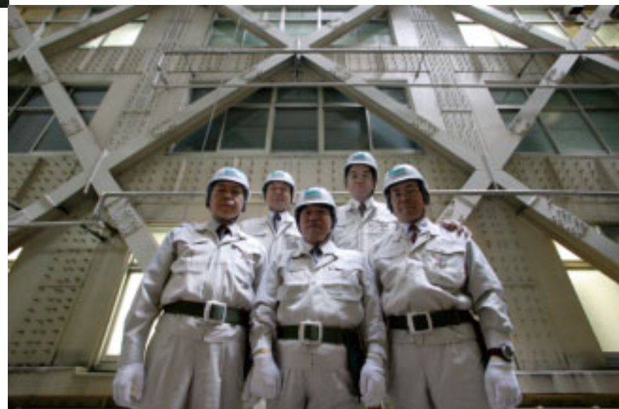
鉄鋼ビル耐震補強工事 撮影日2007年9月21日
