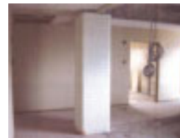
鉄鋼ビルディング耐震補強工事 (平成13年竣工／東京都) 延床面積66,280.04m 2
