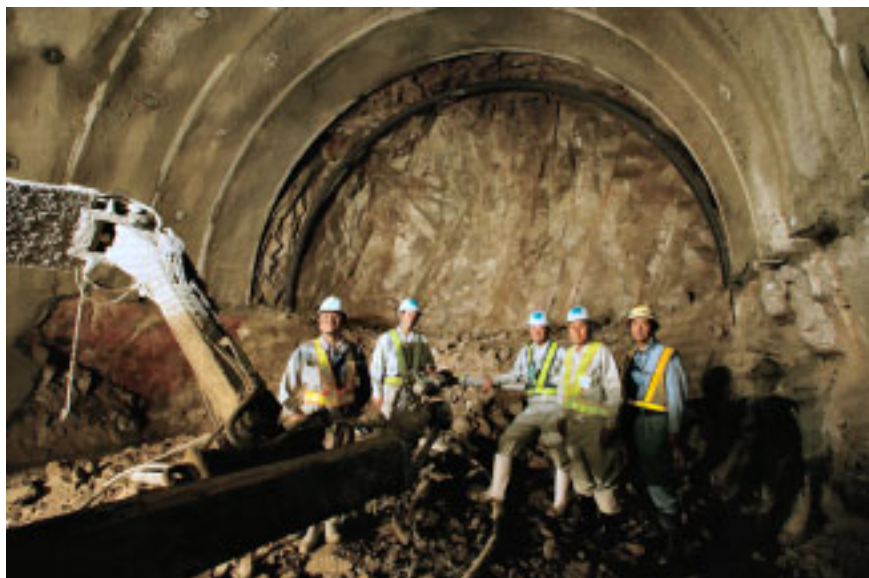
梶矢トンネル工事 撮影日：2007年9月26日
