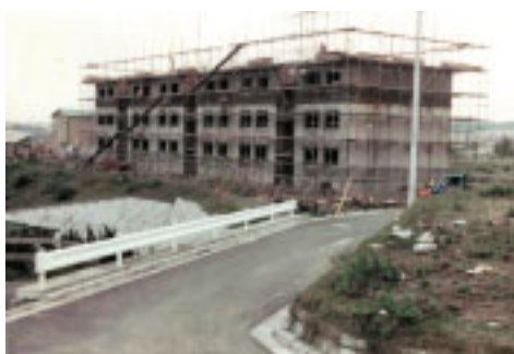
マスオカ・ホームズ (昭和48年／神奈川県横浜市) 鉄筋コンクリート造5階建
