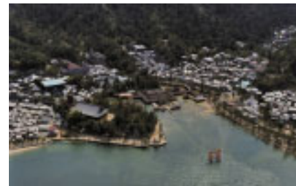
国宝厳島神社修復、維持工事 (昭和40年～／広島県廿日市市)
